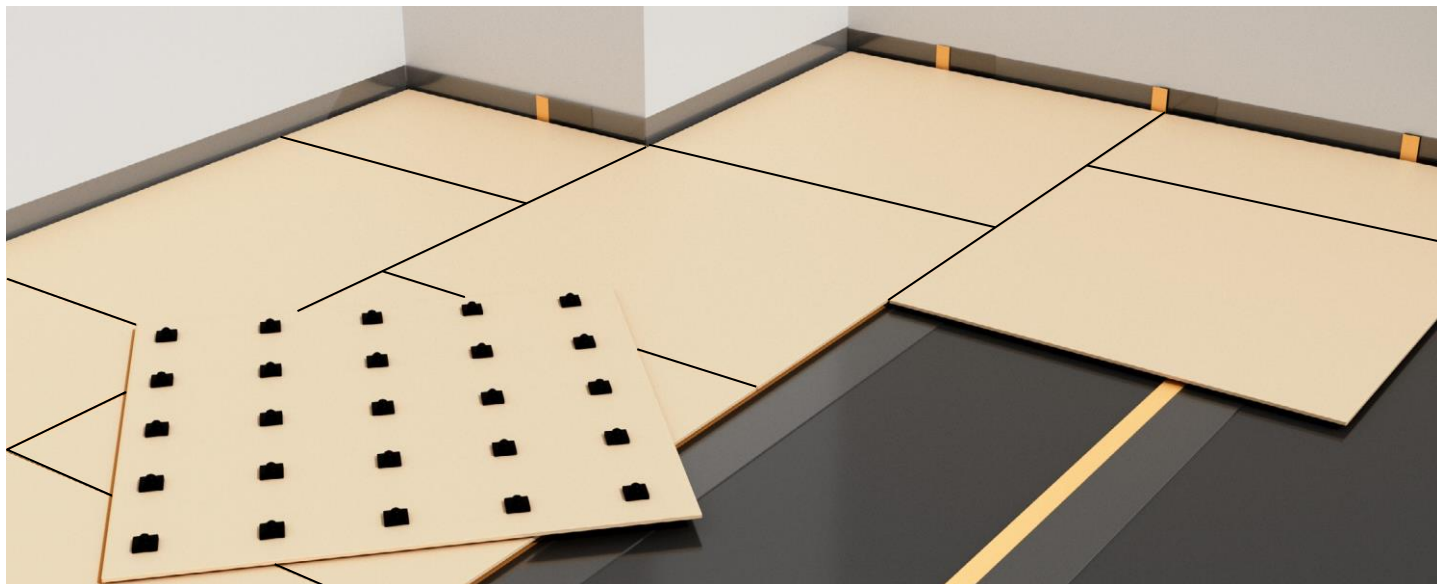
ШАГ 2: установка нижнего слоя фанеры
