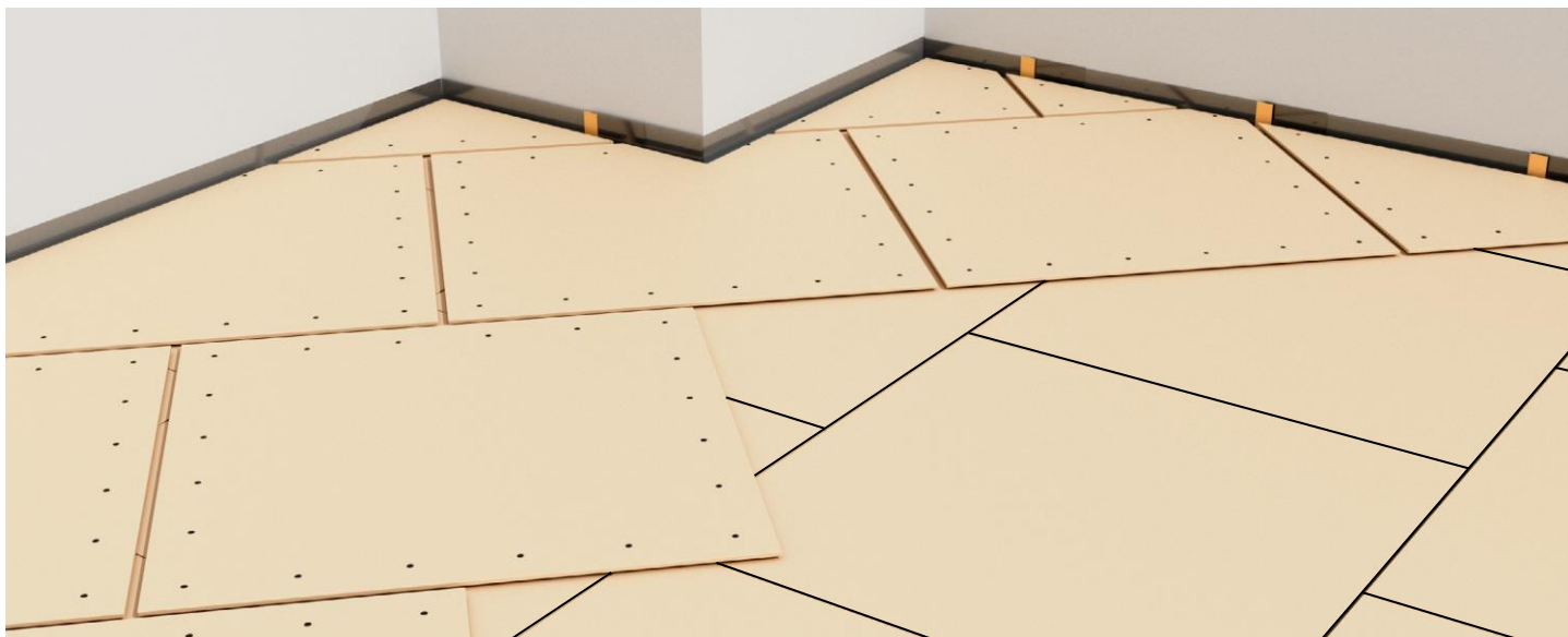
ШАГ 3: установка верхнего слоя фанеры
